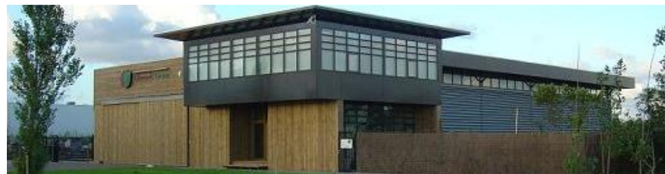
ST.-ANNAPAROCHIE - BEDRIJFSPAND MET KANTOREN EN WERKPLAATS
