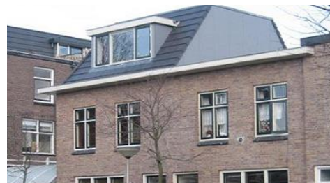
03 - OPBOUW OP PLAT DAK
