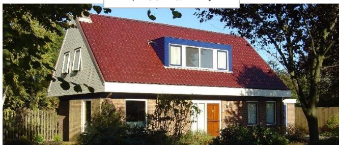
HUIS VOORZIEN VAN NIEUW DAK MET DAKKAPSEL
