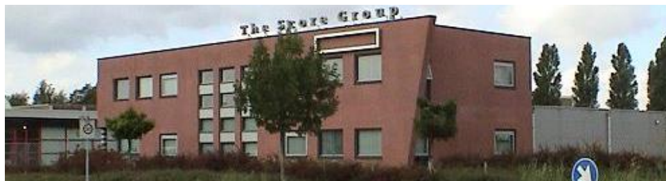
LEEWARDEN - SHOWROOM KANTOREN EN WERKPLAATS
