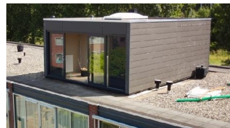
04 - OPBOUW OP PLAT DAK
