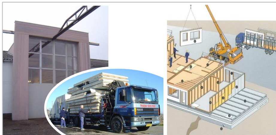
HSB-TRANSPORT VANAF ONS BEDRIJF & MONTAGE OP DE BOUWLOKATIE MET EEN KRAAN
